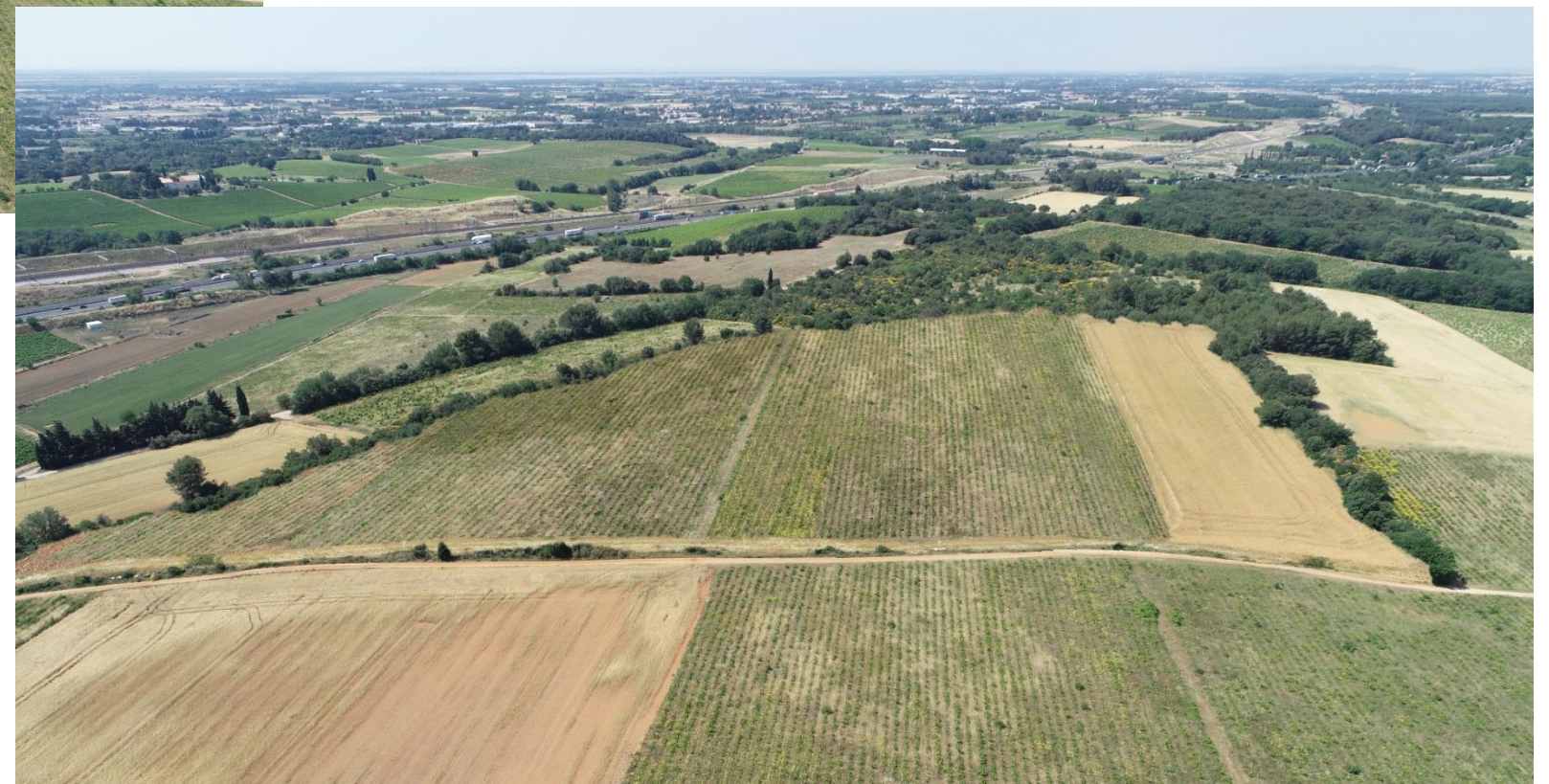
Figure 5 : Etat du site réaménagé
