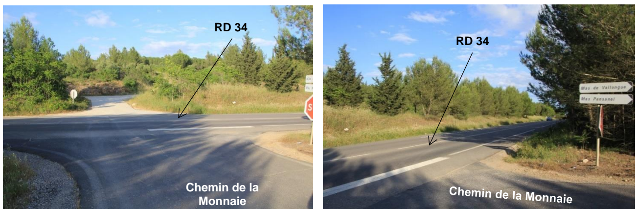
Figure 2 : Carrefour entre la RD34 et le Chemin de la Monnaie
